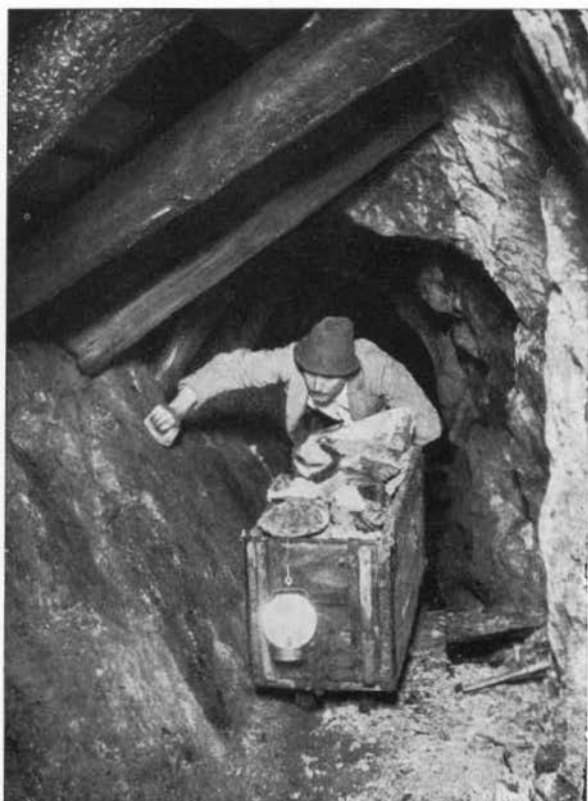
Bergmann mit altem Grubenhunt und Knappenröhl (am Liegenden) im alten Stollen in der Siglitz, Naßfeld
